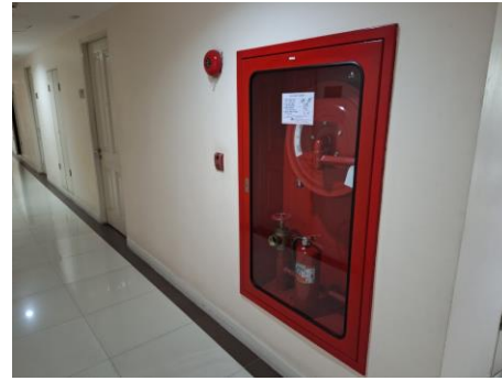
ตู้ FHC และป้ายแสดงวิธีการใช้อุปกรณ์ดับเพลิง
